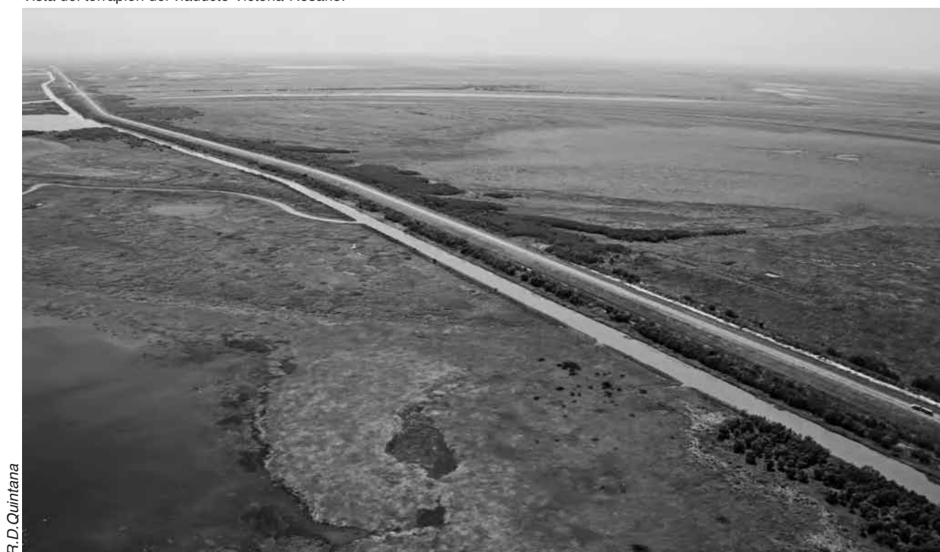
Vista del terraplén del viaducto Victoria-Rosario.
