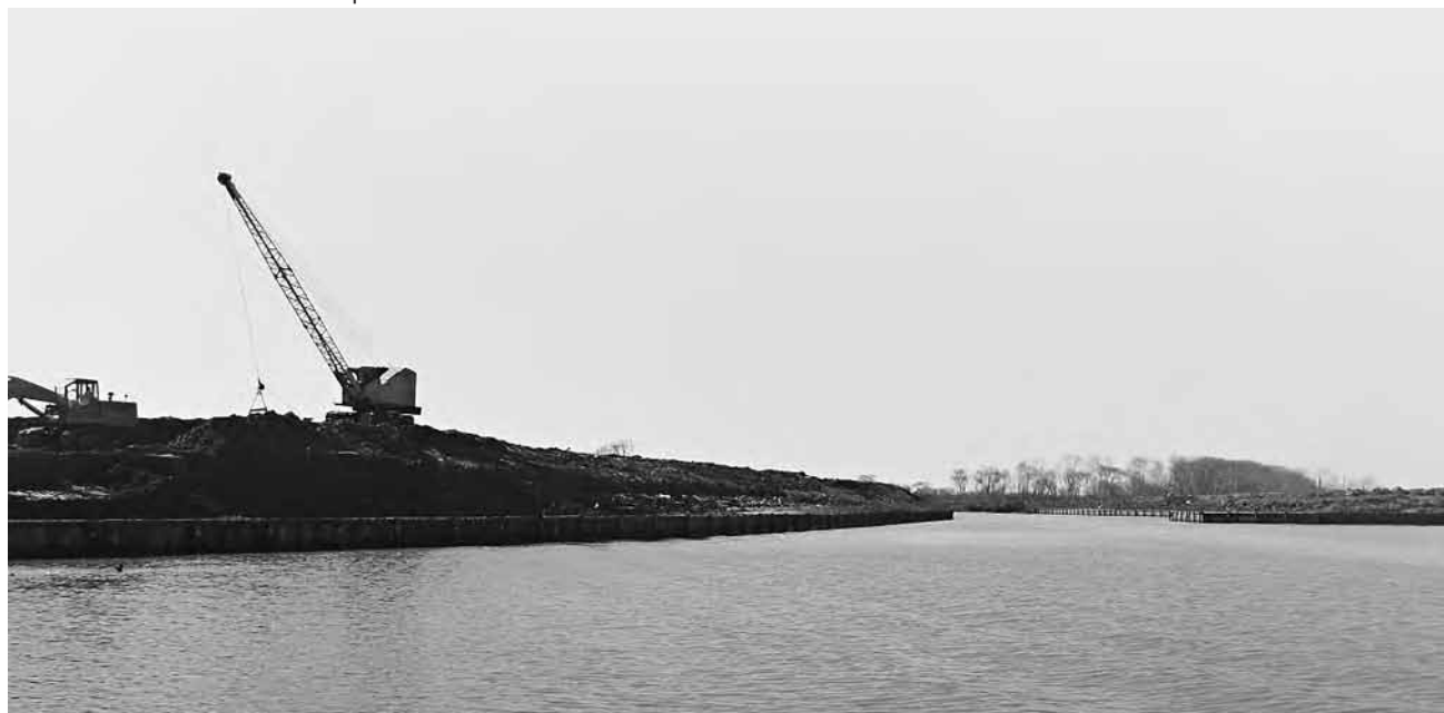
Construcción de endicamientos para infraestructura inmobiliaria.
